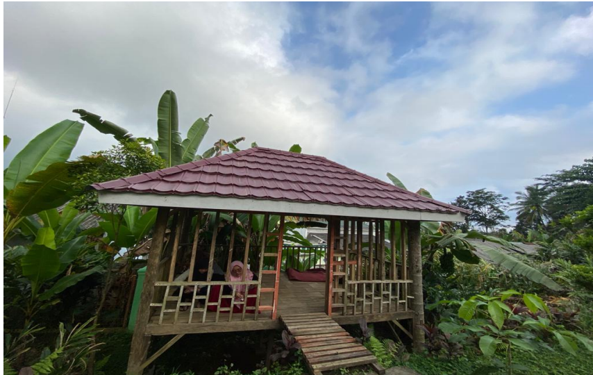
Gambar 4. Kondisi Rumah Baca sebelum Renovasi
