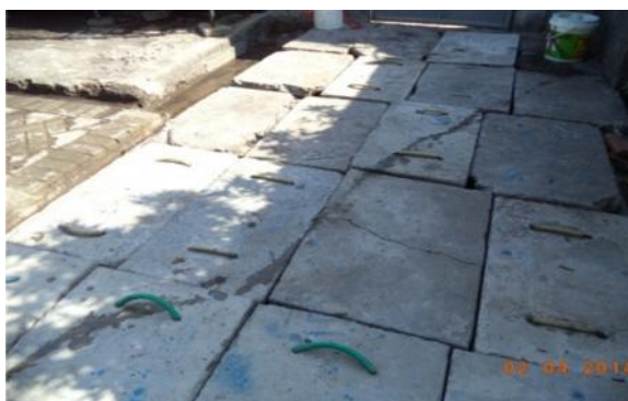
Gambar 17. Instalasi Pengolahan Air Limbah (IPAL)
