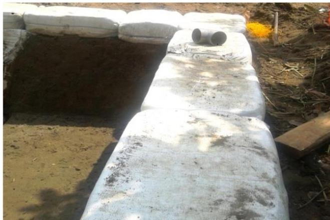
**Gambar 4. Keduk Teplok dan penyusunan Cetakan**
